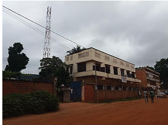
1 Pylône du projet GIRAFE
